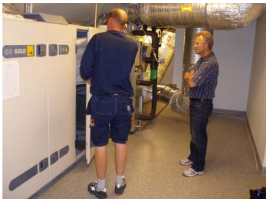
Figur 5 Ett sätt att spara energi för uppvärmning är att behovsstyra ventilationen.
